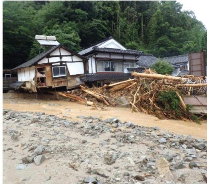
図5. 家屋被害と流木 9)
